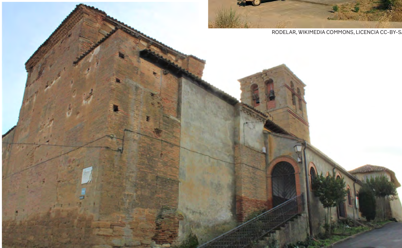
↑ La fachada de la iglesia de San Clemente ha sido dañada por las naves dedicadas al ganado a su alrededor.
