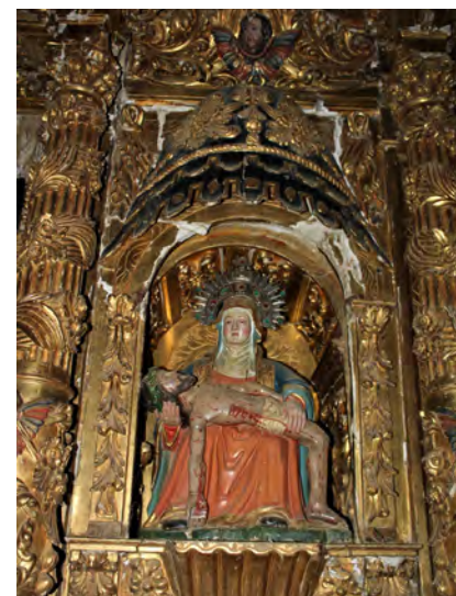
↑ Detalle del retablo mayor con claros signos de deterioro.
