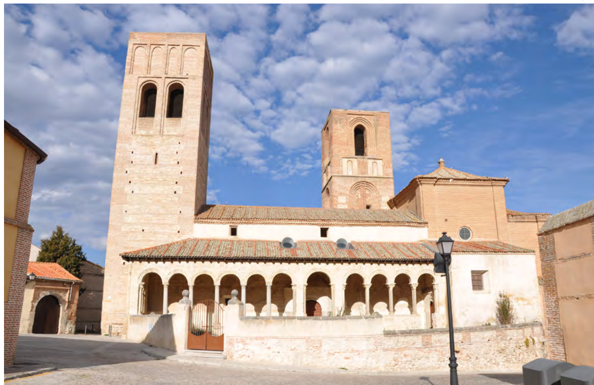
↑ La iglesia de San Martín de Arévalo (Ávila), se construyó entre los siglos XII y XVIII.
