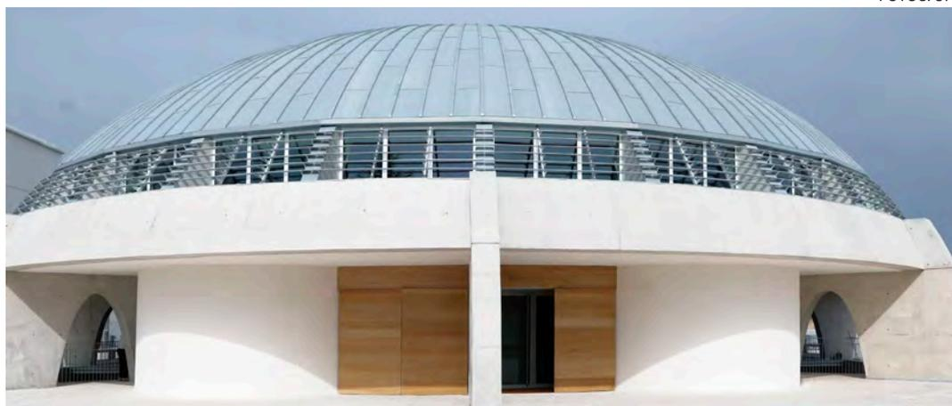
← **La cúpula** está forrada de zinc en el exterior y de madera blanca en el interior.
