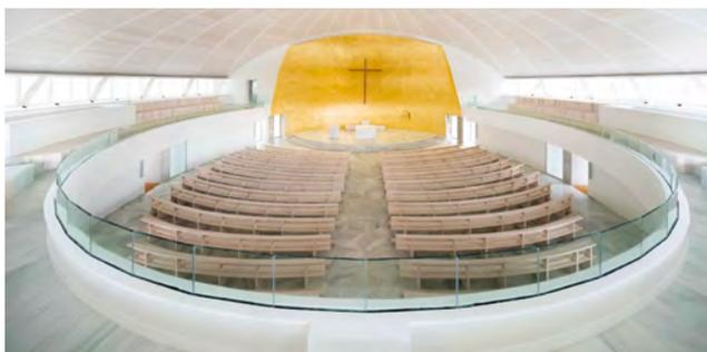
↑ **La cúpula** está forrada de zinc en el exterior y de madera blanca en el interior.
